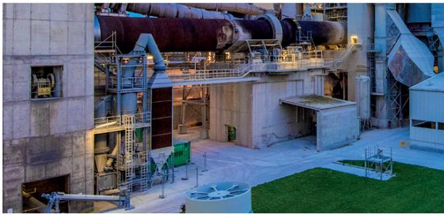
Pilotanlage Oxyfuel-Klinkerkühler, Zementwerk Hannover, HeidelbergCement
