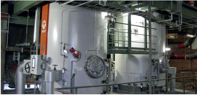
Elektrodenkessel im Heizkraftwerk des Industrieparks Höchst, Frankfurt
