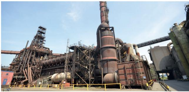
Erdgasbasierte Direktreduktionsanlage, Stahlwerk Hamburg, ArcelorMittal
