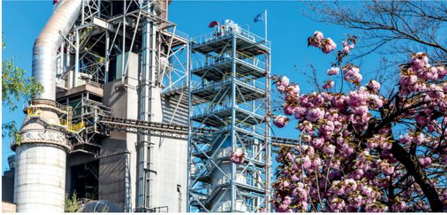
Pilotanlage des LEILAC-Reaktors im Zementwerk Lixhe, HeidelbergCement
